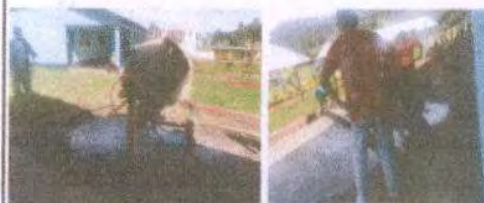
Foto 14: FUNDICION DE PISO
