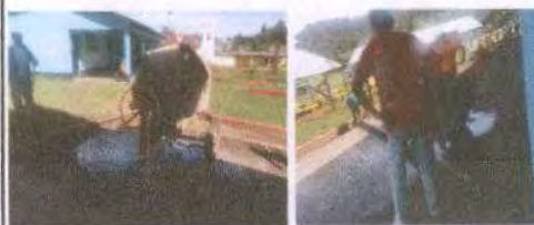
Foto 14: FUNDICION DE PISO
