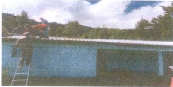
Foto 1: SUSTITUCION DE LAMINA, POR LAMINA TROQUELADA ALUZINC LIBRE 26
