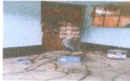
Foto 2: SUSTITUCION DE PUERTA DE MADERA POR METAL
