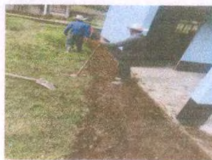
Foto 16: FUNDICION DE BANQUETA
