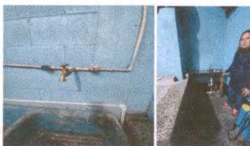
Foto 9: SUSTITUCION DE TUBERIA LINEA PRINCIPAL RED DE AGUA POTABLE
