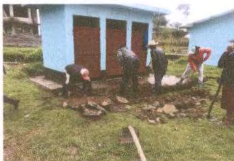
Foto 15: FUNDICION DE PISO FRENTE A SANITARIOS
