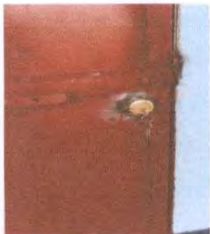
Foto 13: CAMBIO DE CHAPAS MARCA YALE
