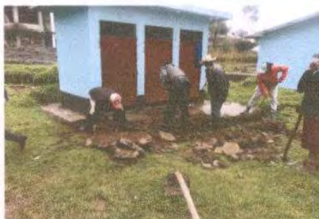
Foto 15: FUNDICION DE PISO FRENTE A SANITARIOS
