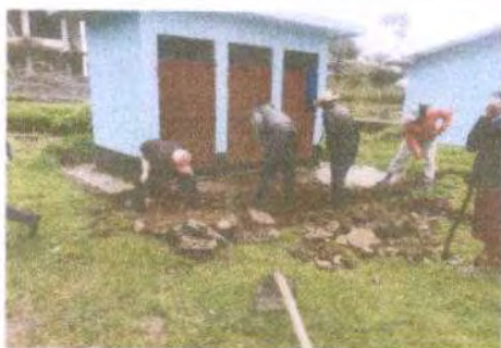
Foto 15: FUNDICION DE PISO FRENTE A SANITARIOS
