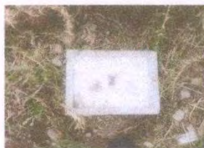
Foto 8: SUSTITUCION DE CAJA DE REGISTRO
