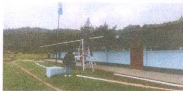
Foto 4: SUSTITUCION DE CANAL PVC
