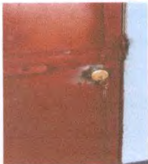
Foto 13: CAMBIO DE CHAPAS MARCA YALE
