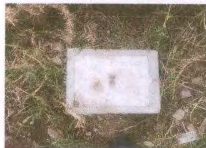
Foto 8: SUSTITUCION DE CAJA DE REGISTRO
