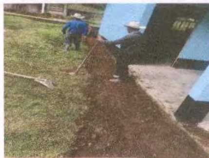
Foto 16: FUNDICION DE BANQUETA
