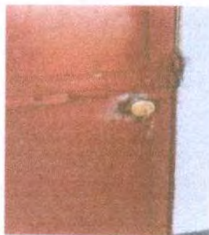
Foto 13: CAMBIO DE CHAPAS MARCA YALE
