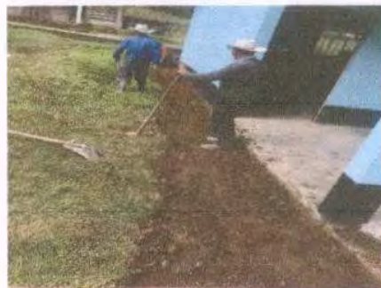
Foto 16: FUNDICION DE BANQUETA
