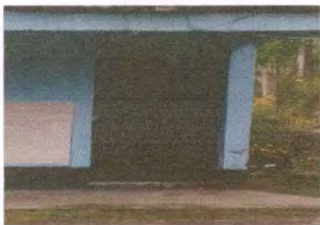
Foto 17: PINTURA DE PUERTA DE METAL
