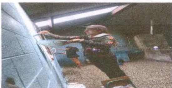
Foto 5: PINTURA EN MUROS EXTERIORES E INTERIORES
