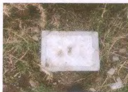
Foto 8: SUSTITUCION DE CAJA DE REGISTRO
